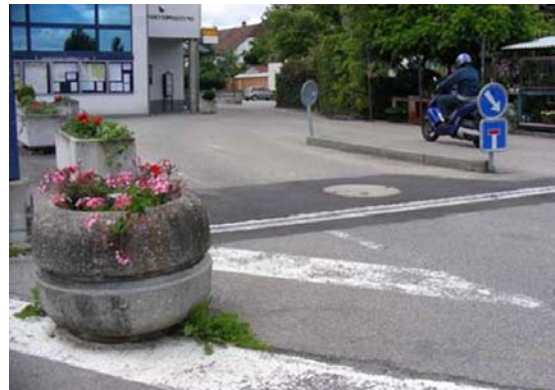
Abbildung 3 Eine Vielzahl von unterschiedlichen Gestaltungselementen („Möblierung“, Signalisationen und Bodenbeläge) wirken sich negativ auf das Erscheinungsbild der Aussenräume aus.
