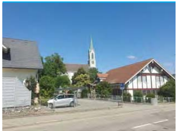
Kirchweg, Blick aus Nordosten
