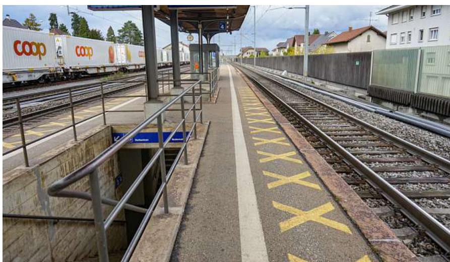
Um den Abstand zwischen Geländer und Sicherheitslinie zu vergrössern, wird das Perron verbreitert.
